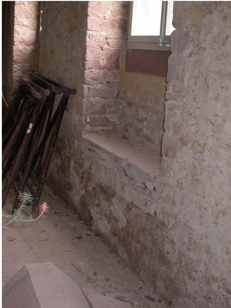
Die Größe der ursprünglichen Fenstertüren ist am Mauerwerk ablesbar
